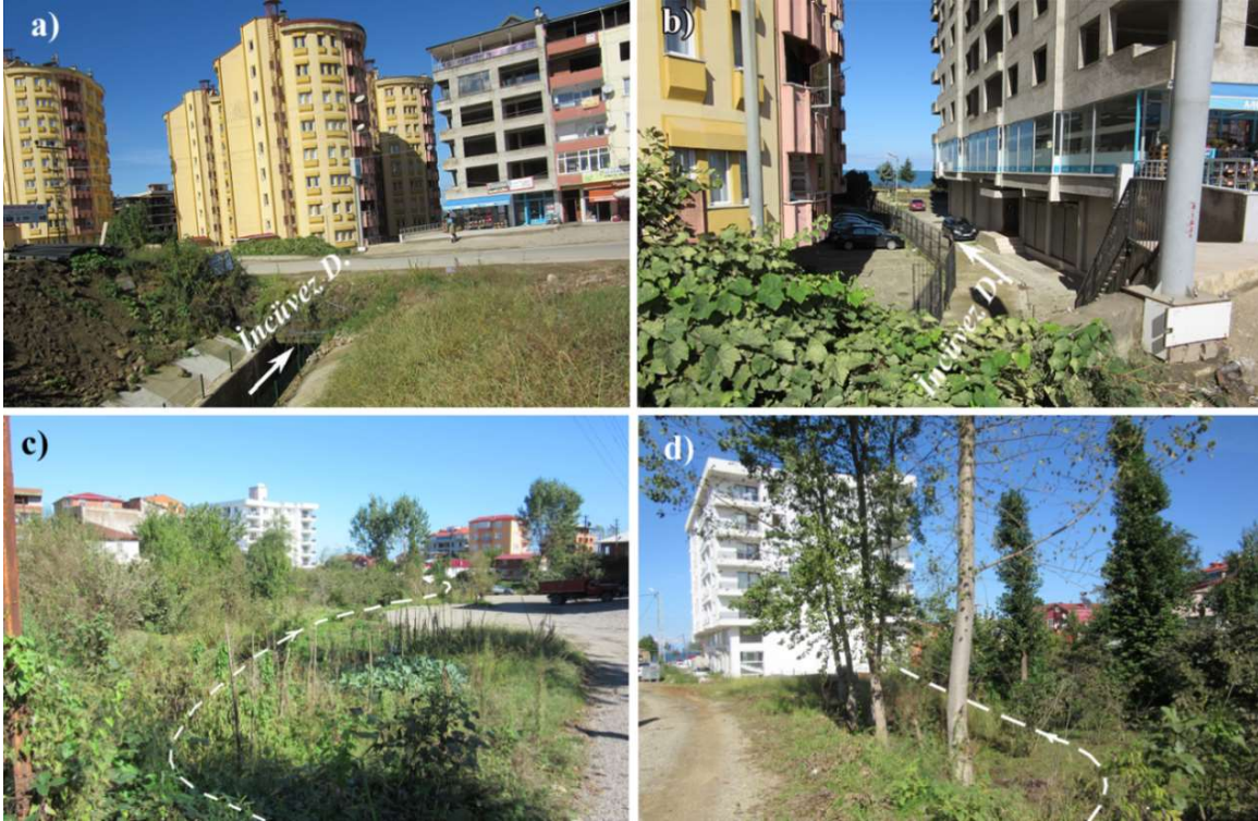
Foto 2. Pazarsuyu Deresi batısında İncüvez (a, b) ve diğer akarsu vadilerinde yapılan binalar (c, d). Aşağı havzada dere yataklarında mesken yapımı ve akarsuların kanala alınması sel ve taşkınlara neden olmaktadır.
