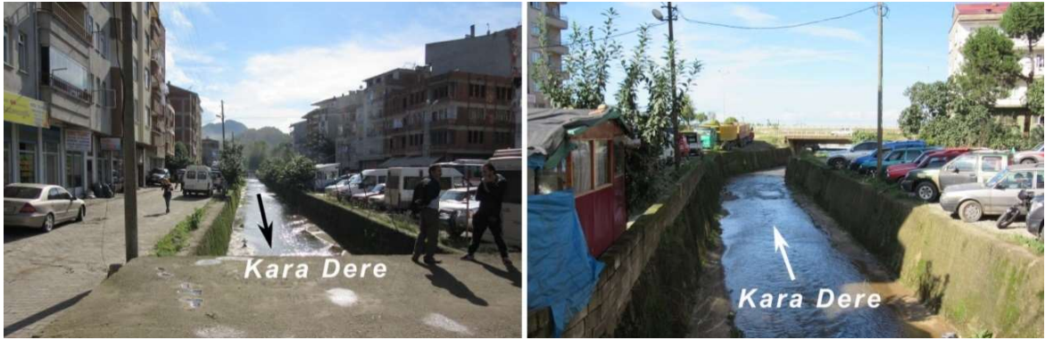
Foto 3. Kara Dere'nin Bulancak içerisinde kalan bölümü kanala alınarak yatağı daraltılmıştır. Bu müdahale nedeniyle şiddetli yağışların görüldüğü dönemde taşkınlar yaşanmaktadır.
