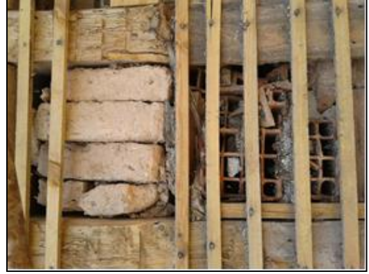
Şekil 1: Geleneksel Kastamonu Evleri dış duvar dolgu malzemesi
