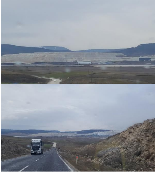
Şekil 1. Atık bor sahası
