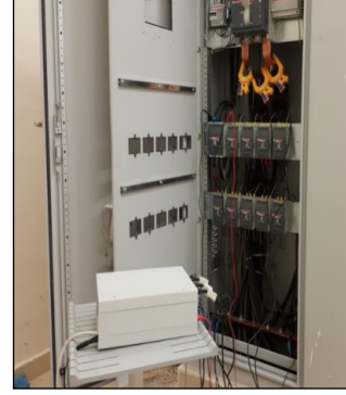
(a) İzleme cihazının ölçüm noktasına bağlantı şekli.
