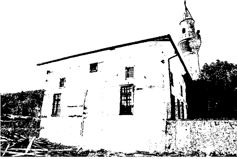
Görsel 5: Caminin güney cephesi
