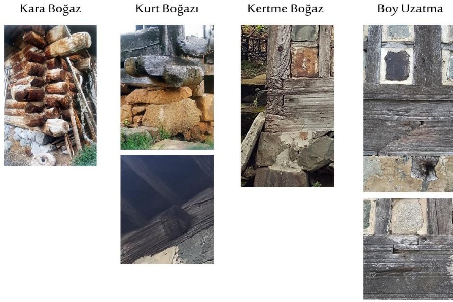
Şekil 2: Doğu Karadeniz Kırsal Mimarisinde Birleşim Detayları
