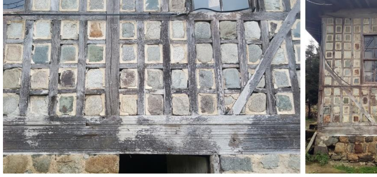
Şekil 7: Göz dolma duvar
