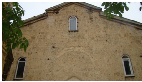
Foto 15. St. Basil Kilisesi Batı Cephesi
