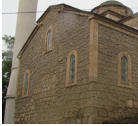
Fotoğraf 16. St. John Kilisesi Batı Cephesi
