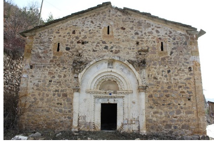
Fotoğraf 12. Demirkapı Köyü Meryemana Kilisesi Batı Cephesi
