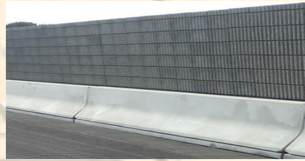
Şekil 12: Beton gürültü bariyeri görseli (Anonymous, 2018)
