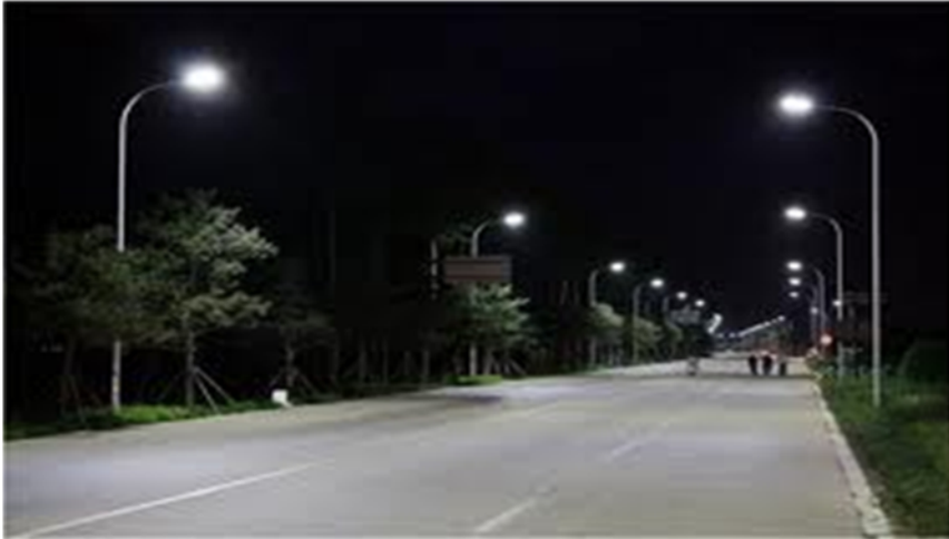
Resim. 2. LED Lamba ile Sokak aydınlatması
