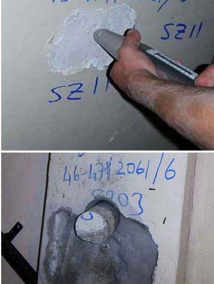
Şekil 6 : Test çekici uygulamaları ve karot numune alma işlemi
