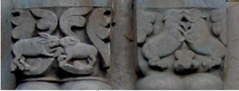
Fotoğraf 114-115. Çamlıyamaç (Öşk) Manastırı Kilisesi, hayvan figürleri (Anfora Mimarlık Arşivi).
