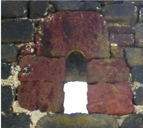
Fotoğraf 191. Börk Şapeli, renkli taş uygulaması.
