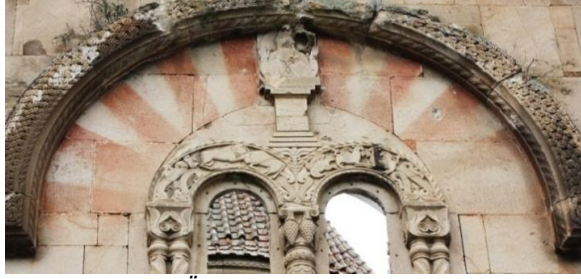
Fotoğraf 180. Çamlıyamaç (Öşk) Manastırı Kilisesi, boyama tekniğinde sahte kemer düzenlemesi.
