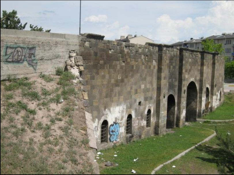
Foto. 21: İstanbul Kapısı'nın günümüzdeki durumu
