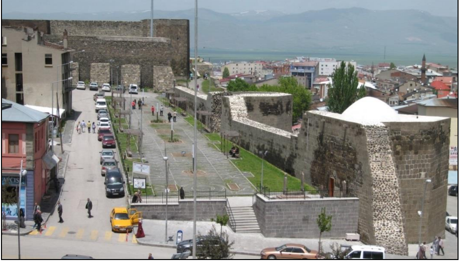
Foto. 7: Tebriz Kapısı'nı İç Kaleye bağlayan sur duvarı ve burçlar
