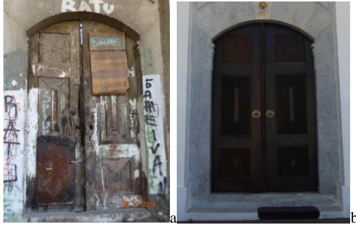
Resim 14. Ahşap kapının onarım öncesi görünümü (a) ve onarım sonrası görünümü (b). (Kaynak: Yazarlara ait fotoğraf arşivi, 2013, 2017).
