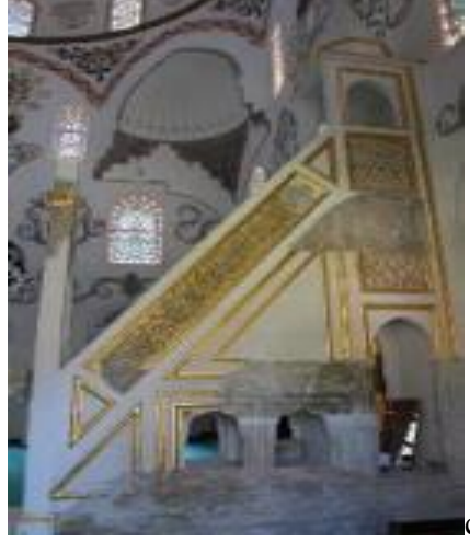
Resim 12. Kırık minber parçalarının bütünleme detayı ve mermer minberin konservasyon ve restorasyon sonrası hali. (Kaynak: (a-b)- Vakıflar Genel Müdürlüğü arşivi-2016 (c)-Yazarlara ait fotoğraf arşivi-2017).
