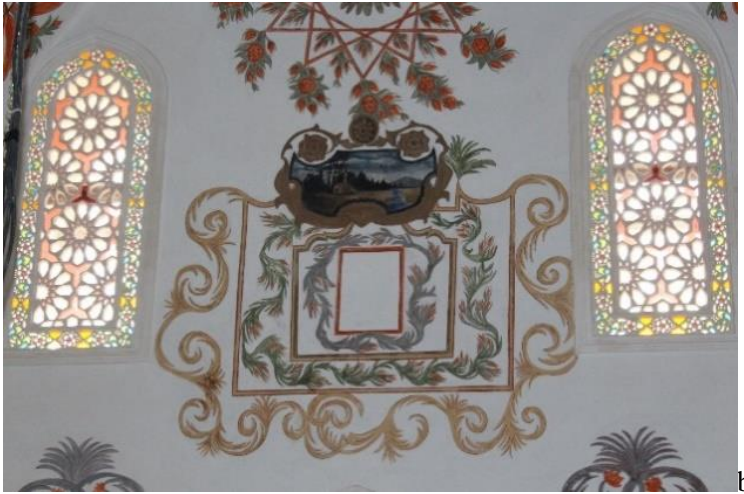
Resim 27. Raspa sonrası tespit edilen II. Dönem kalemîşi bezeme (a), noktasal ihya çalışması sonrası görünümü (b). (Kaynak: Yazarlara ait fotoğraf arşivi, 2015, 2017).
