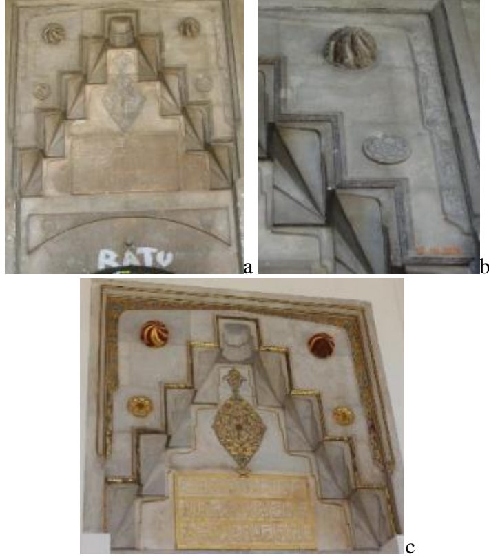
Resim 23. Portal üzerindeki kalemişi ve altın varaklı bezemenin restorasyon öncesi (a, b) ve restorasyon sonrası görünümü (c). (Kaynak: Yazarlara ait fotoğraf arşivi, 2014, 2017).
