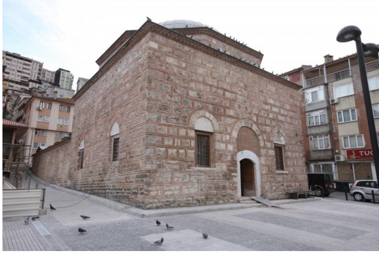
Fotoğraf 23: Emir Sultan Hamamı Genel Görünüm
