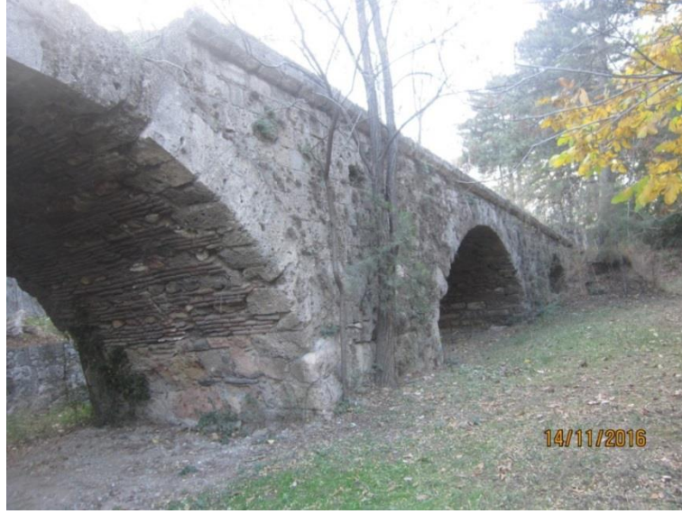
Fotoğraf 21: Mihraplı (Selçuk Hatun) Köprüsü Genel Görünümü
