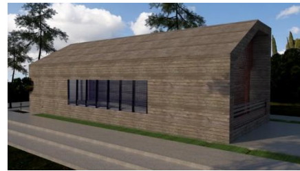
Şekil 9: Cephe ile bütünleşik kullanılan FV panel uygulaması (Cephe-2)
