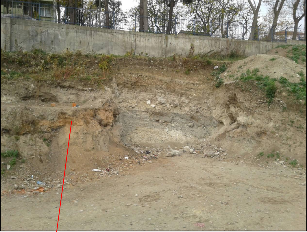
Resim 10: Kazı öncesi 3 nolu alandan görünüm.
