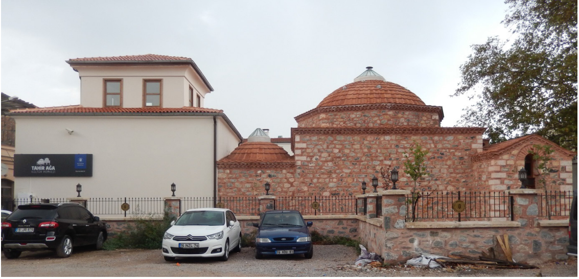
Resim 9. Tahir Paşa Hamamı Yan Cepheden Görünüm, (Müderrisoğlu, 2016).
