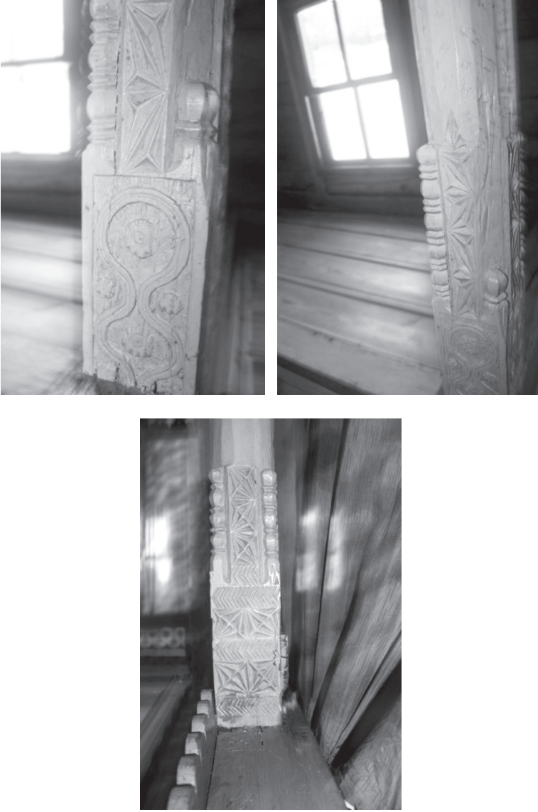
Foto 17-18-19: Mahfilde bulunan Üst Örtüyü Taşıyan Ahşap Direkler
