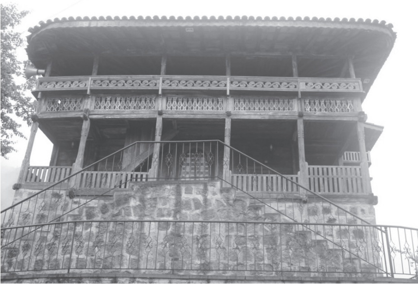
Foto 2: Bilen Köyü Camii Kuzey Cephe
