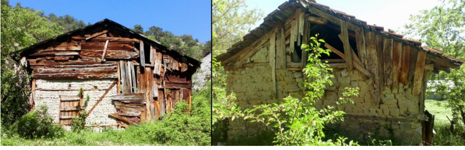
Şekil 7. Orta Durumdaki Samanlık Yapıları
