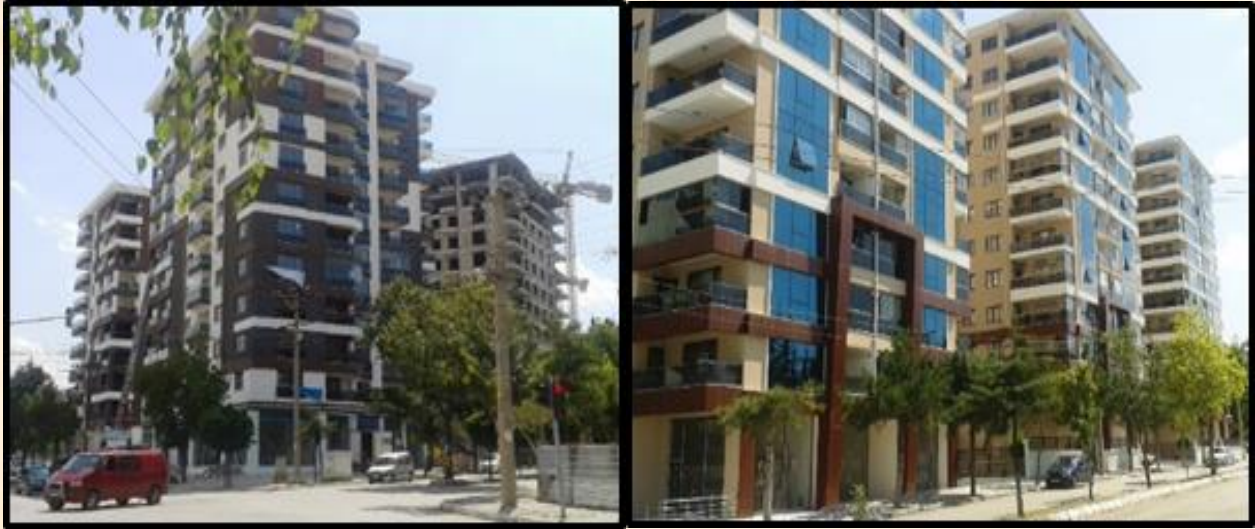
Şekil 3.4. Isparta İli, Gülistan Mahallesi kentsel dönüşüm sonrası oluşan yüksek katlı yapılar.
