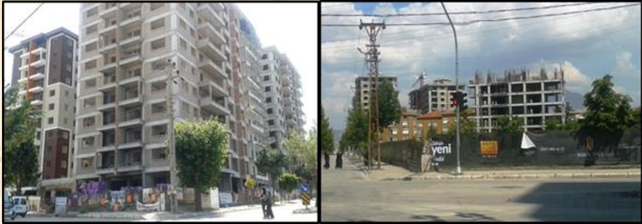
Şekil 3.1. Isparta İli, Gülistan Mahallesi’ndeki kentsel dönüşüm çalışmaları.
