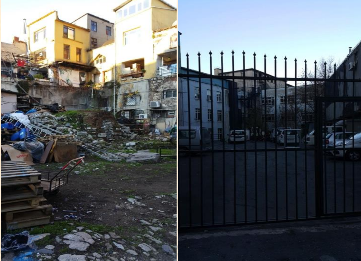
Şekil 12. Balkapan Hamı'nın avlusundan görünüm (solda), Türk Telekom binasının bahçesinin görünümü (sağda), (25.12.2017)
