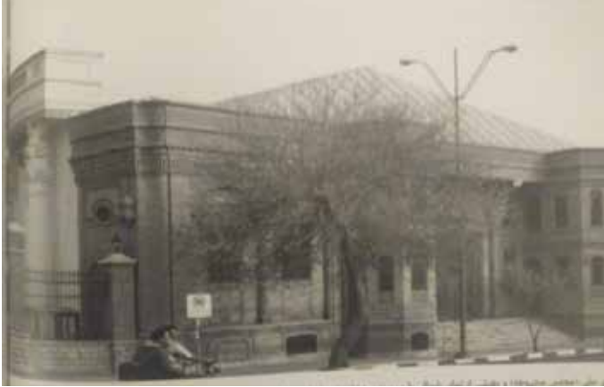
G. 2. Birinci Meclis Binası (1934) Mimar: Kerim Tâhîrzâde (Vahid Ghobadian, a.g.e)
