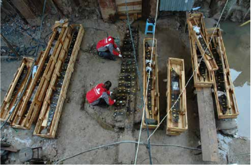
G. 4: Batık ahşaplarının sökülmesi (İÜ Yenikapı Batıkları Projesi Arşivi)
