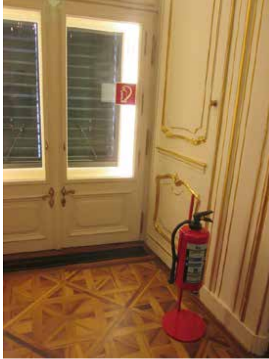
G.5 Viyana Schonbrunn Saray Müzesinde yangın söndürücünün tahribatsız olarak yerleştirilmesi ve işaretlendirilmesi (A. Kuzucuođlu Arřivi)
