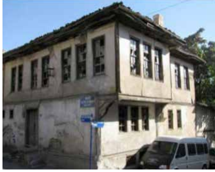
G. 27. Restorasyondan Önceki Görünümü (Çankırı Kültür Envanteri'nden)
