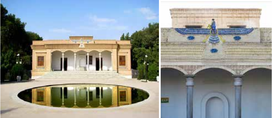
G. 6. (Solda) Yazd Zerdüşti Ateşkesesi (1934) Genel Görünüşü ve (Sađda) Cephesinde Kullanılan Furuher Simgesi (Arash Kazemivand Niar) Mimar: Anonim, Cemşid Emanet (Vahid Ghobadian, a.g.e)
