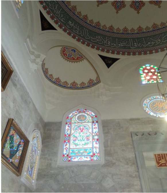
Fot.: 4 Caminin ana kubbesi ve trompların duvarla birleşimleri (Fotoğraf yazara aittir).
