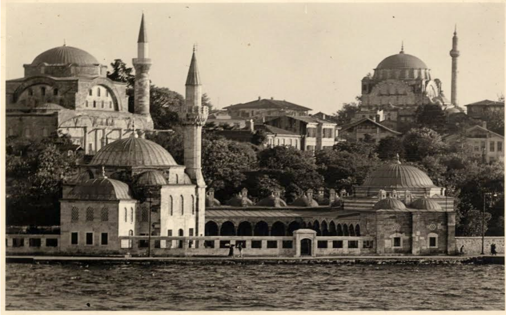
Fot.: 1 Yapının denizden görünümü
