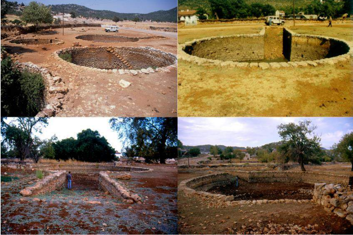
Şekil 12. Yavu polye tabanındaki antik kuyu kalıntıları, günümüzde yörede rastlanan ayaklı (yolaklı) göletlere benzemektedir.
