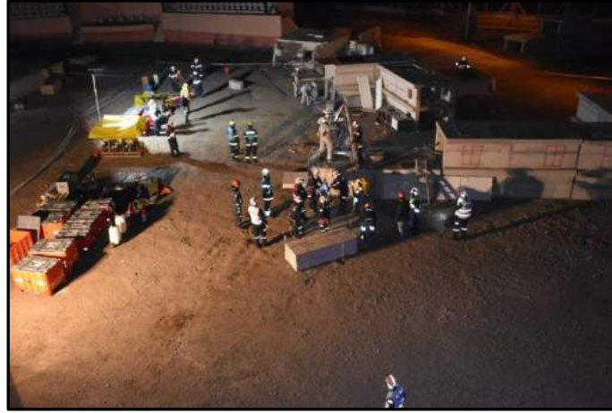
Şekil 5. Enkaz bölgesindeki saha çalışmalarından bir görüntü
