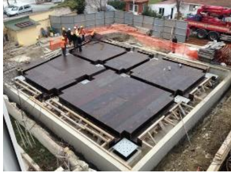
Şekil 5. Temelde Yalıtım Sistemi (Web 3, 2017)
