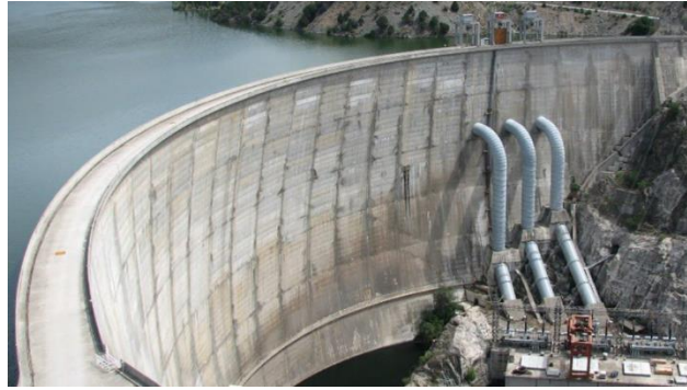
Resim 8. Gökçekaya Barajı, Eskişehir; 1967 [17]
