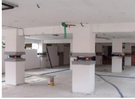
Şekil 6. Kolon Orta Bölgesinde Yalıtım Sistemi (Web 4, 2017)
