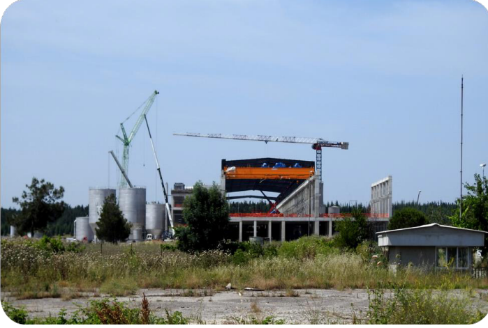
Foto 1. Paşaköy Termik Santral İnşaatı Alanı
