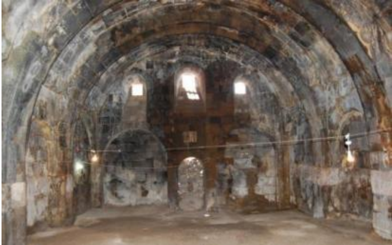
Foto. 7: Saint Croix Kilisesi, batı duvar
