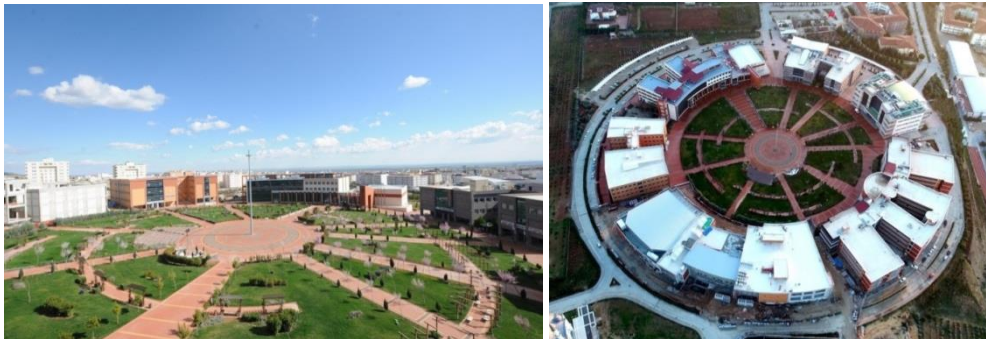
Şekil 12. Projenin tamamlanmış hali
