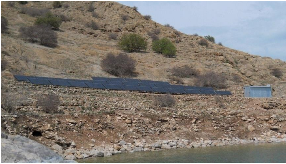
Şekil 2. Akdamar Adası güneş enerjisi uygulaması
