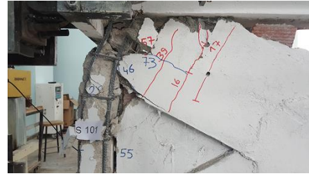
Kolonlarda kabuk betonun dökülmesi sonucu donatılarda akma ve köşe bölgelerin ezilmesi
