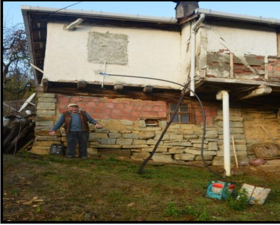
Foto 30 ve 31. Geleneksel yapı malzemesine ulaşım güçlüğü nedeniyle konutlarda tahrip olan kısımlarda modern yapı malzemesi kullanılmaktadır (Solda-Boyabat) Kaynak: Anonim (Sağda-Gürsöktü Köyü Ayancık).
