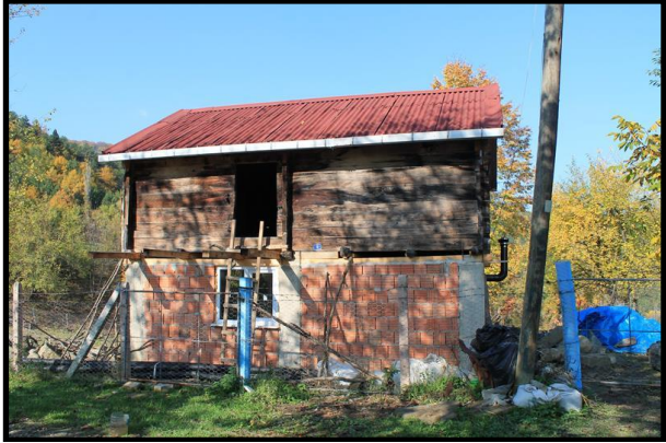
Foto 26 ve 27. Yörede geleneksel mimarinin en önemli sembollerinden olan köy ambarlarının hava akımının sağlanması amacıyla boş bırakılan alt kısımları modern malzeme ile kapatılarak konuta çevrilmektedir (Solda-Babaçay Köyü/Ayancık) (Sağda- Bakırlı Zaviye Köyü/Ayancık).
