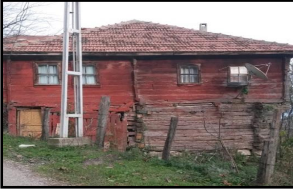
Foto 12 ve 13. Ahşap yapıların dış cephelerinin gelişigüzel malzeme kullanılarak boyanması (Solda - Dolay Köyü/Ayancık) ya da ahşap malzemenin çimento ile sıvanması (Kurtköy/Ayancık) konutların ömrünü kısaltmaktadır.
