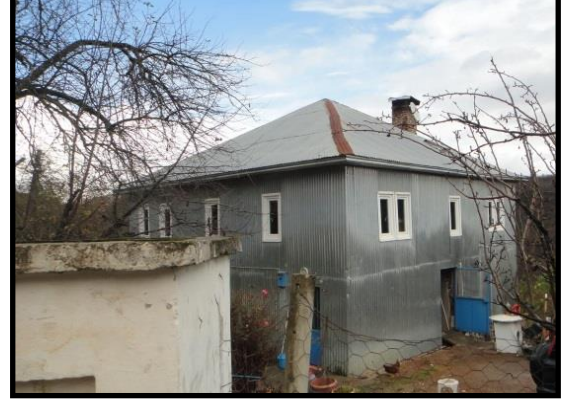
Foto 5. Çatısı ve dış cephesi sac örtü ile kaplanmış, pencereleri PVC sistemle değiştirilmiş bir konut (Akören Köyü/Ayancık)
