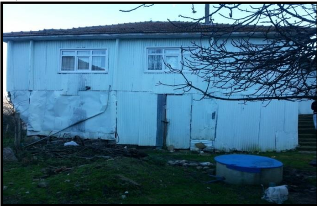
Foto 8 ve 9. Evin dış cephesindeki kaplama malzemesi de ekonomik seviyeye göre değişmektedir. Ekonomik durumu elverişli olanlar kaplama için sac malzeme kullanırken (solda-Yusuflu Köyü/Türkeli) ekonomik durumu elverişli olmayanlar plastik malzeme tercih edebilmektedir (sağda- Karakestane Köyü- Ayancık)
