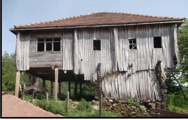
Foto 4. Dış cephe kaplaması olarak ahşap malzeme kullanılan bir konut (Doğanlı Köyü/Ayancık)
