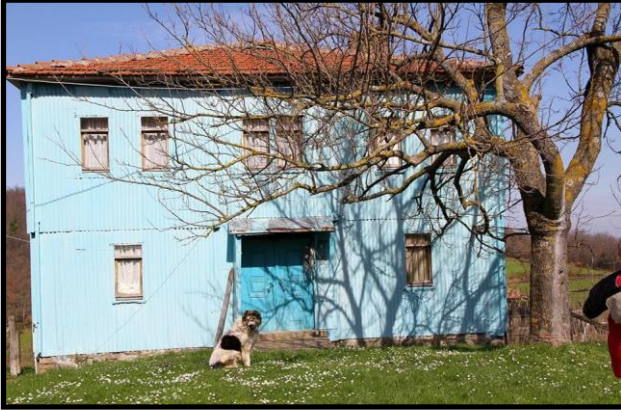
Foto 6. Dış cephesi sac örtüyle kaplanmış bir konut (Akçaçam Köyü /Erfelek).
