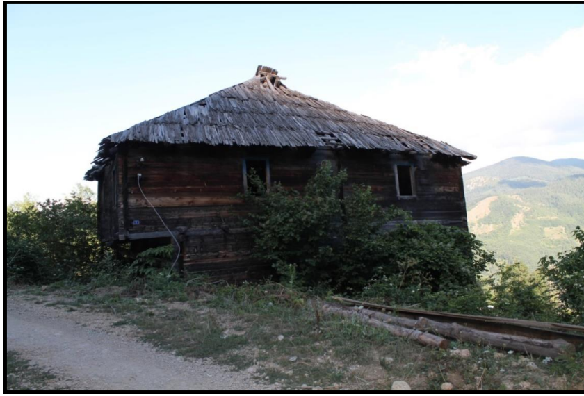
Foto 2. Çatı örtüsü olarak pedavra adı verilen ahşap malzemenin kullanıldığı eski bir köy camisi (İnaltı Köyü/Ayancık).
