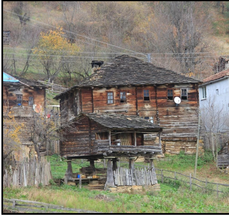
Foto 1. Sinop yöresinde ahşap-taş malzeme birlikteliğiyle inşa edilmiş geleneksel kır meskeni ve aynı özelliklere sahip köy ambarı (Kurtköy/Ayancık)
