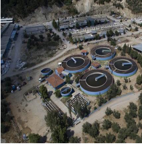
Fotoğraf 3: Arıtma Tesisi (2018)
