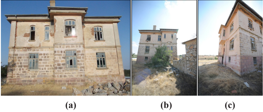
Şekil 7. Mehmet Ağa Konağı'nın Batı (a), Kuzey (b) ve Kuzeydoğu (c) Görünüşleri (2017)[14]
