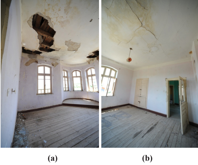
Şekil 19. Mehmet Ağa Konağı'nın 1. Kat 110 (a) ve 111 (b) Oda Mekânları (2017)[14]
