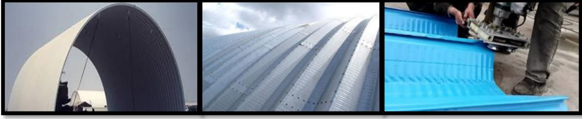
Şekil 3. Kemerli çelik levha kesitlerinin uygulaması
