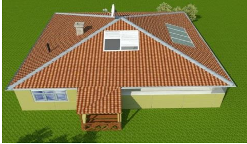
Şekil 6. Konutun çatısına yapılması planlanan cam ve panjur sistemi
