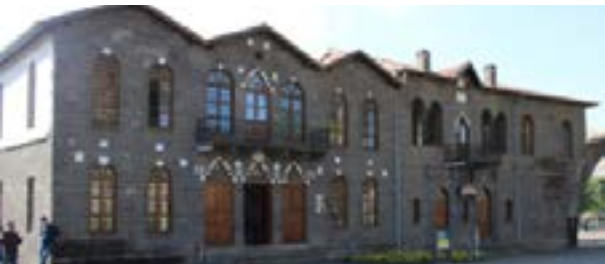
Foto. 5: Müze İdari Binası
