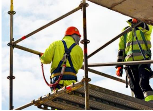
Şekil 1. Yapı iskelesi platformu güvenli çalışma örneği
