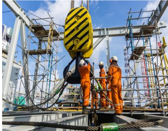
Şekil 6. Kule vinç kanca bakımı güvenli çalışma örneği
