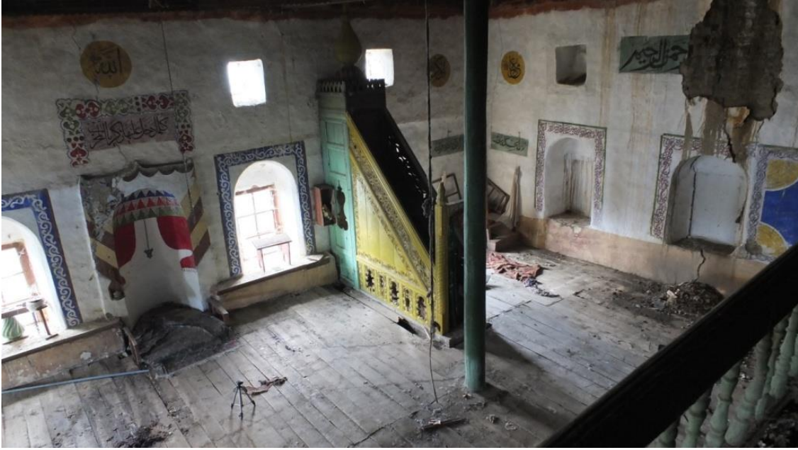
Fotoğraf 19: Mihrap, Minber ve Batı Duvarı Bezemeleri
