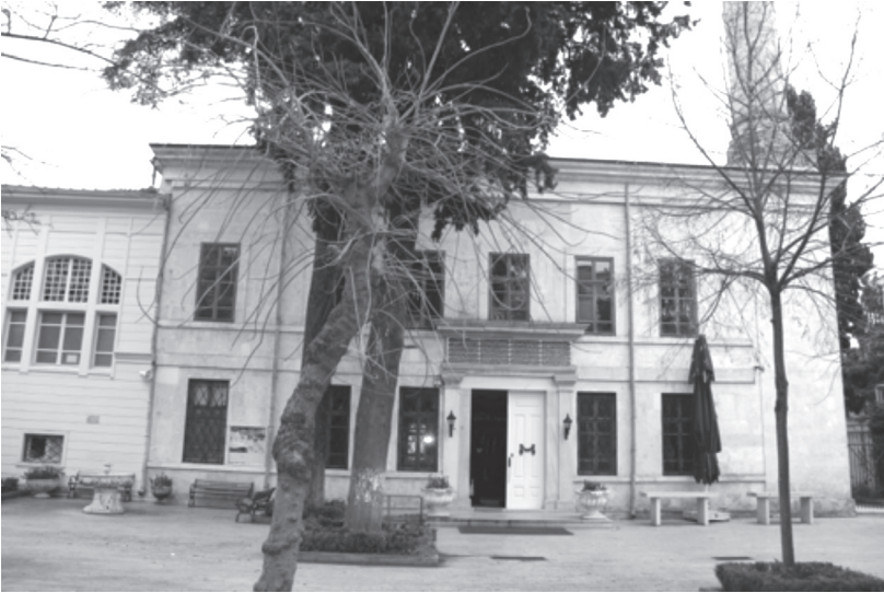
Ek 2. Emirgan Hamid-i Evvel Camii Giriş Cephesi (N. Bezci, 21.4.2018)
