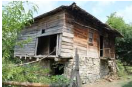
F.20. Şahinkaya Köyü 6 Nolu Ev
