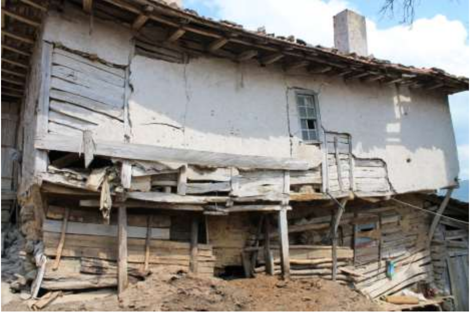
F. 35. Meşelitürkmenler Köyü 4 Nolu Ev
