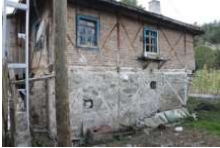
F.25. Bengü Köyü 2 Nolu Ev
