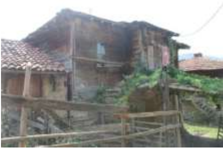
F.15. Şahinkaya Köyü 1 Nolu Ev
