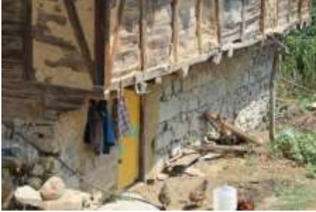
F.33.Meşelitürkmenler Köyü 2 Nolu Ev
