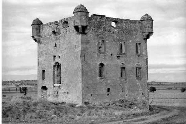
Res.6. Konağın güneydoğudan görünüşü
