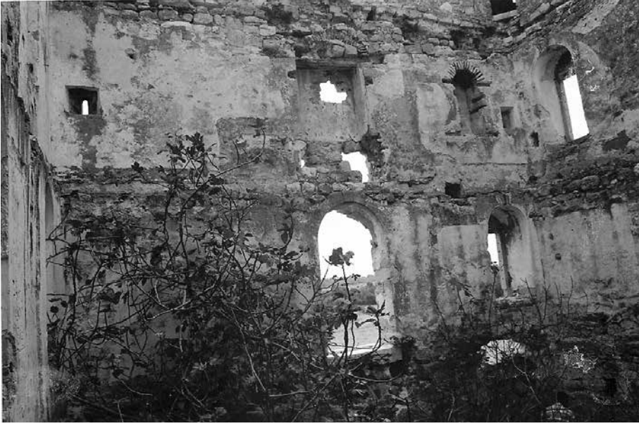
Res.17. İç güney cephe
