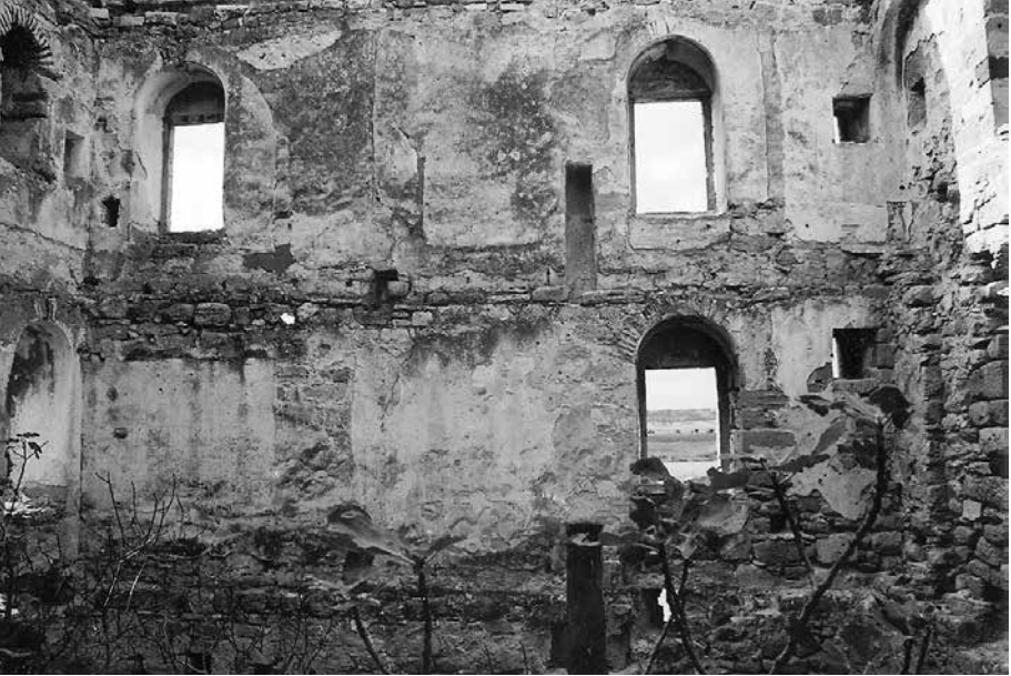
Res.16. İç batı cephe
