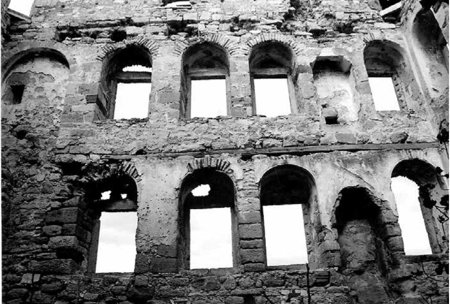
Res.14. İç kuzey cephe
