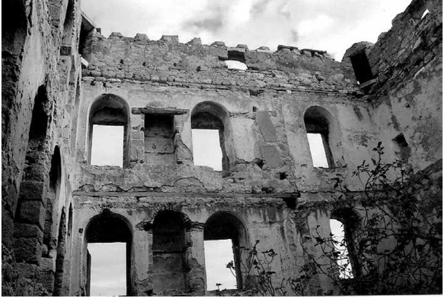
Res.13. İç dođu duvarı
