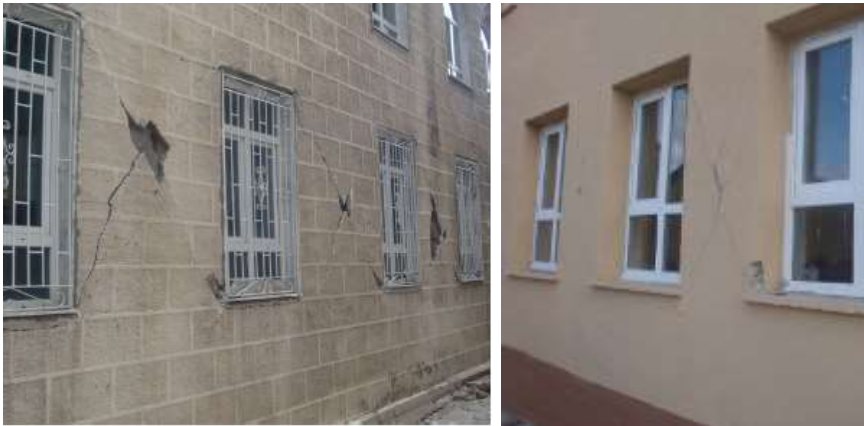
Şekil 16. Van depreminden sonra görülen pencere kenarı taşıyıcı ve fonksiyonel elemanlardaki kesme hasarı örnekleri (Bedirhanoğlu ve Önal (2011)).
