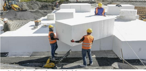
Şekil.4. Geofom bloklor
