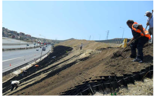
Şekil.3. Yol şevlerinde erozyon koruması
