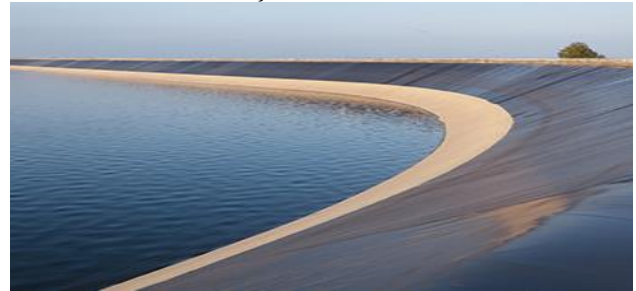
Şekil.2. Geomembran uygulaması
