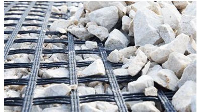
Şekil.4. Geogridle yapılan dolgu uygulaması
