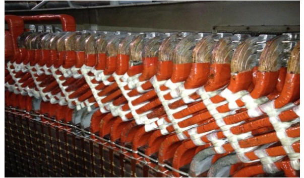
Şekil 6. Stator sargılarının montajı
