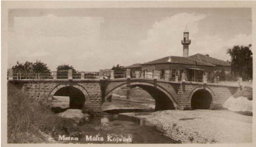
Şekil 4. Mersin Müftü Köprüsü Kaynak: http://caltibozkir.tr.gg/MERSIN-.htm
