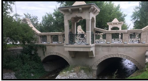
Şekil 4.5. Köfke Taşı Köprü Uygulaması, Isparta (Yüksel, 2018)
