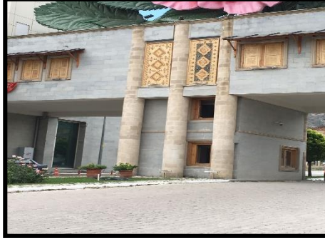
Şekil 4.4. Geyran Taşı (Andezit) Duvar Kaplaması ve Köfke Taşı Sütun Uygulaması, Isparta (Yüksel, 2018)
