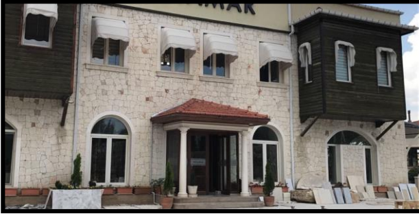
Şekil 4.3. Kireç Taşı (Limra) Kıрма Duvar Kaplaması ve Sütun Uygulaması, Isparta (Yüksel, 2018)
