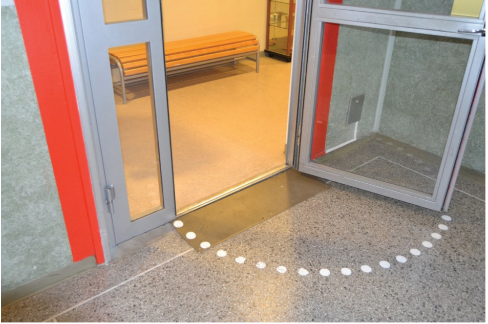
Resim 3: Sensörlü olarak belli açıda kendiliğinden açılıp kapanan kapılar.
