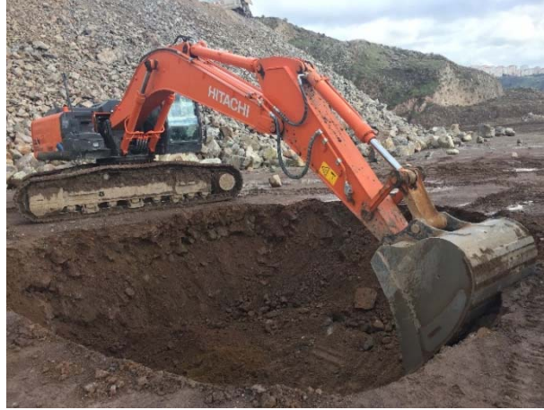
Şekil 7. Ölçümler için sahada yapılan kazı çalışması.
