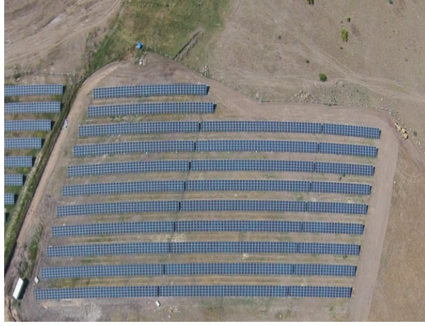
Şekil 4. Albatur enerji GES tesisi.
