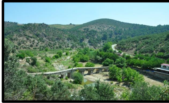
Fotoğraf 1.12. Hacıhıdır Köprüsü Gördes Çayı Üzerinde İnşa Edilmiştir (Fotoğraf Yazar Tarafından Çekilmiştir).
