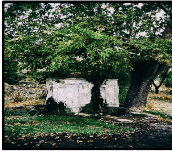
Fotoğraf 1.10. Eski Gördes'teki Tarihi Çeşme Derin Olmayan Süslemelerle Bezenmiştir (Fotoğraf Yazar Tarafından Çekilmiştir).
