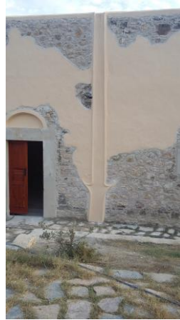
Resim 12: Cephelerdeki yağmur suyu tahliye kanalları
