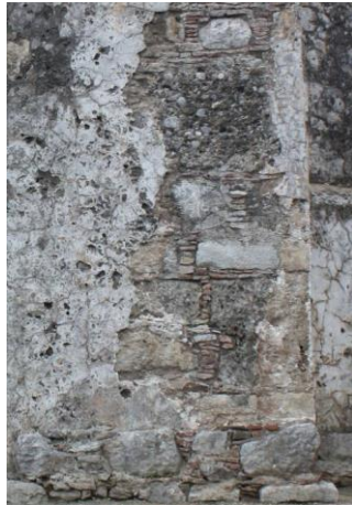
Resim 3: Cephelerde kullanılan taş ve tuğla malzeme
