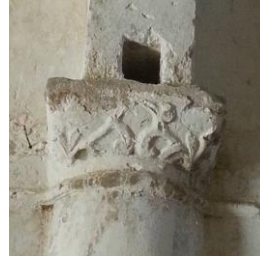
Resim 14: Duvar payesindeki stuko süslemeler
