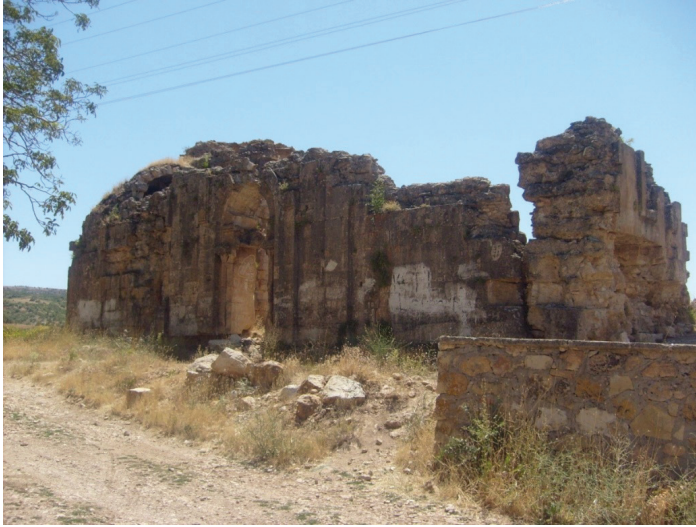
Fotoğraf No: 2- Ergan (Erkayn-Enkuzik) Kilisesi'nin Kuzey Beden Duvarından Genel Görünüm.
