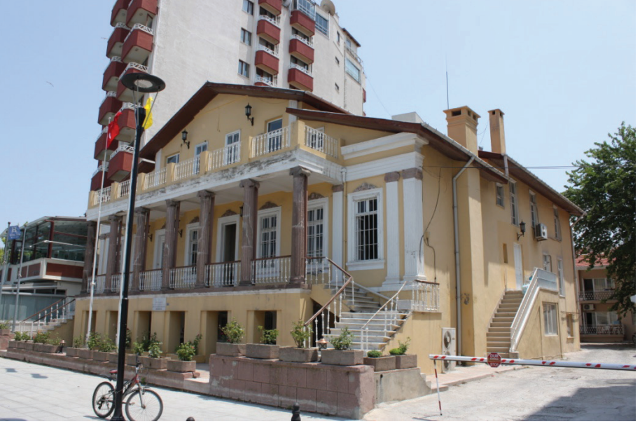
Res. 13: Whittall Konağı, restorasyon öncesi. (2013).
