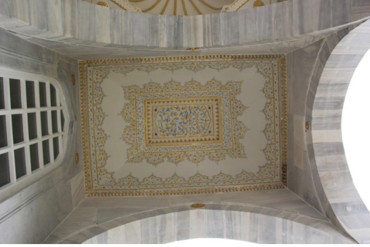
Res.9- Revakın yan bölümünün tonozu (2018)
