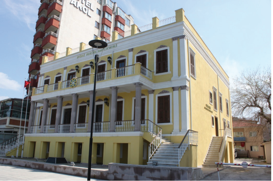
Res. 14: Whittall Konağı, restorasyon sonrası. (2016).
