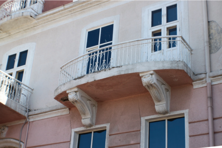
Res. 4: Vitalis Konağı, ön cephedeki balkon çıkmaları ve konsollar. (2013).
