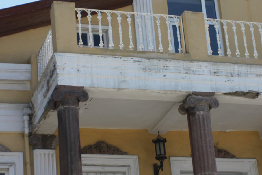
Res. 16: Whittall Konağı, ön cephe detayı. (2013).
