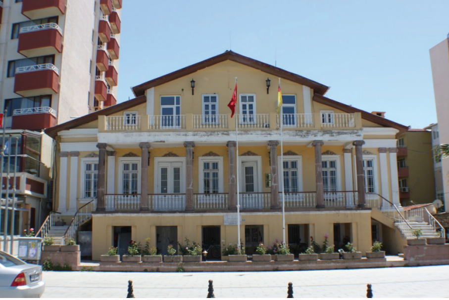
Res. 15: Whittall Konağı, ön cephe. (2013).
