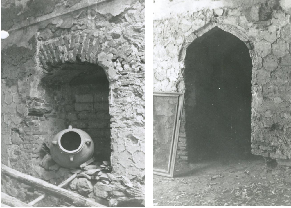
Resim 9-10. 1970'lerde batı yöndeki eyvanın duvarlarında çiniler, harç izleri (TVBMA).
