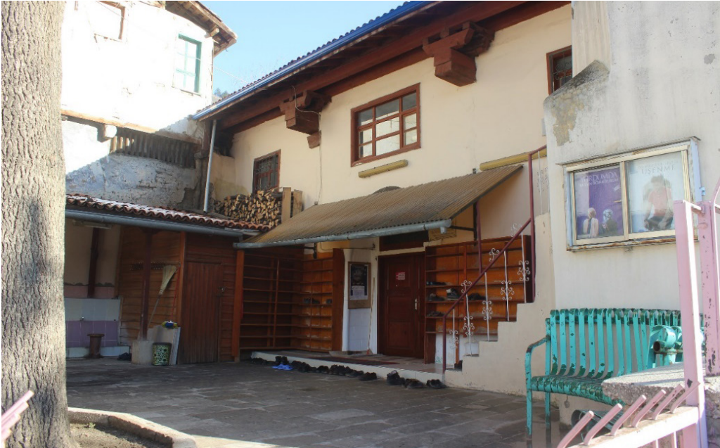
Resim 2. Üzümlören Ulu Camii Kuzey Cephe
