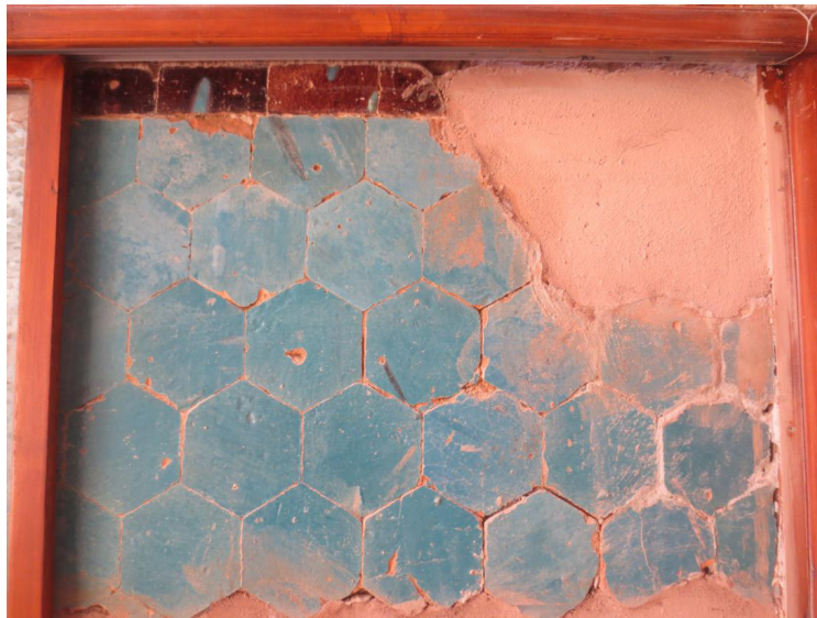
Resim 29. Yağıbasan Medresesi, güney eyvandaki çiniler (A.Denknlbant Çobanoğlu, 2017)
