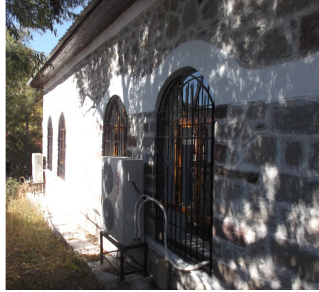
Resim 4. Caminin Restorasyon Sonrası Güney Cephesine Yerleştirilen Pencereler
