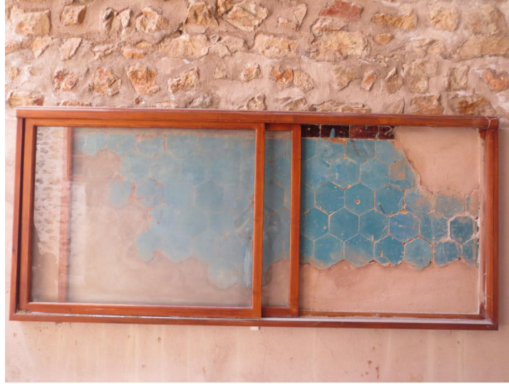
Resim 28. Yağıbasan Medresesi, güney eyvandaki çiniler (A.Denknlbant Çobanoğlu, 2017)
