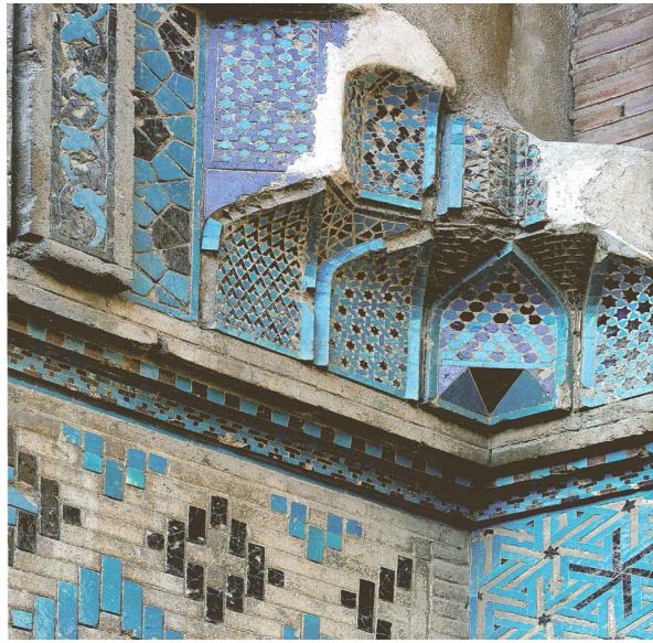
Resim 24. Konya Sırçalı Medrese, giriş eyvanı (Arık, 2007a)
