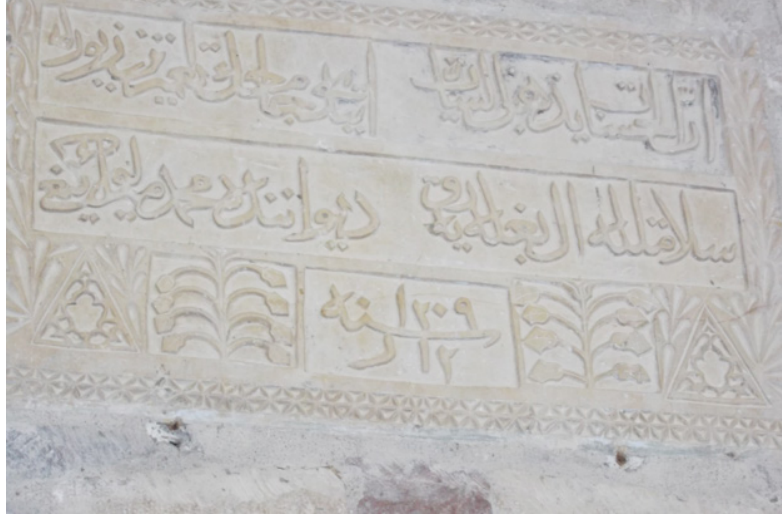
Resim 3. Piltan Bey Camisi Onarım Kitabesi ( Hicri 1209): “İnnel-hasanate yüzhıbné’s-seyyiat Etti cami’inin tamirin tezyîn-i ziverle Selamet-lillaha el bağlayarak Divanında Muhammed Mir-livâ-yı Kiğı 12 Rabiulahir Sene 1209” (Demir, 2008: 53).
