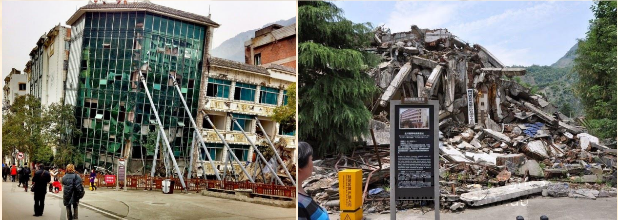
Şekil 14: 2008 Depremi ile açık hava müzesi olarak bırakılan Beichuan Beldesi ( https://www.amusingplanet.com/2014/06/beichuan-preserved-ruins-of-earthquake.html ).
