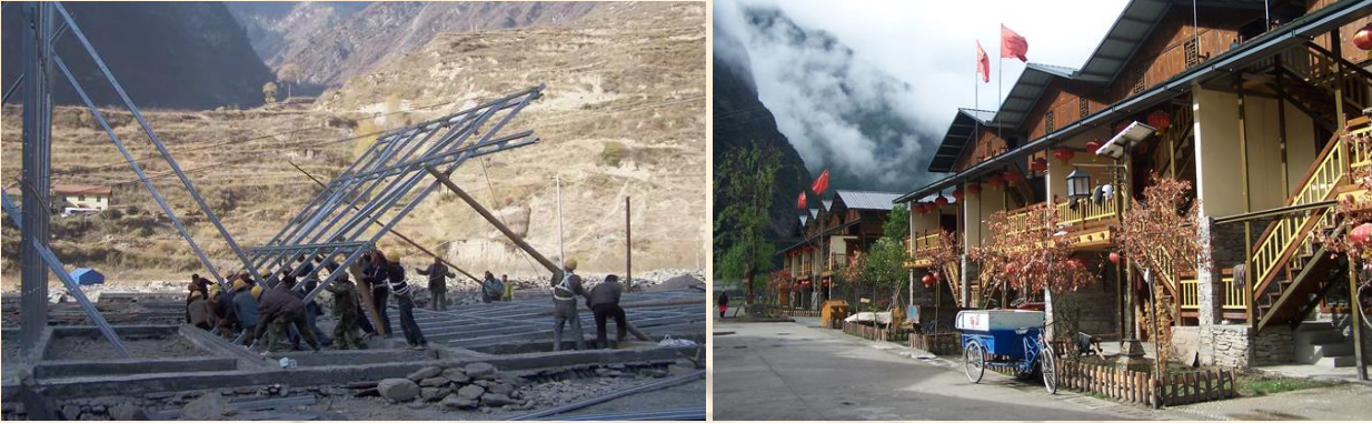
Şekil 6: Evlerinin inşasında görev alan Qiang'lar, bir hafif çelik çerçeve elemanı ayağa kaldırırken. (Sol: https://www.architectureforpeople.org/architects/hsieh-ying-chun/ Sağ: https://www.architecturalrecord.com/articles/8521-yanqliu-village-housing?v=preview ).
