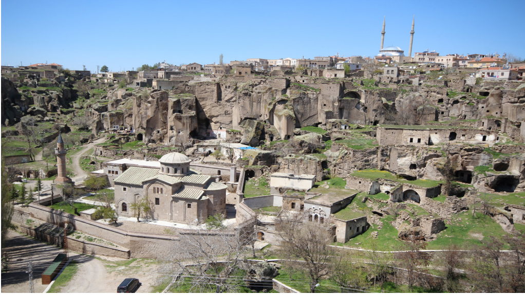
Resim 8. Güzelyurt (Gelveri) Kilise Cami, Güney ve Doğu Cepheler, Güneydoğudan Bakış (2013).
