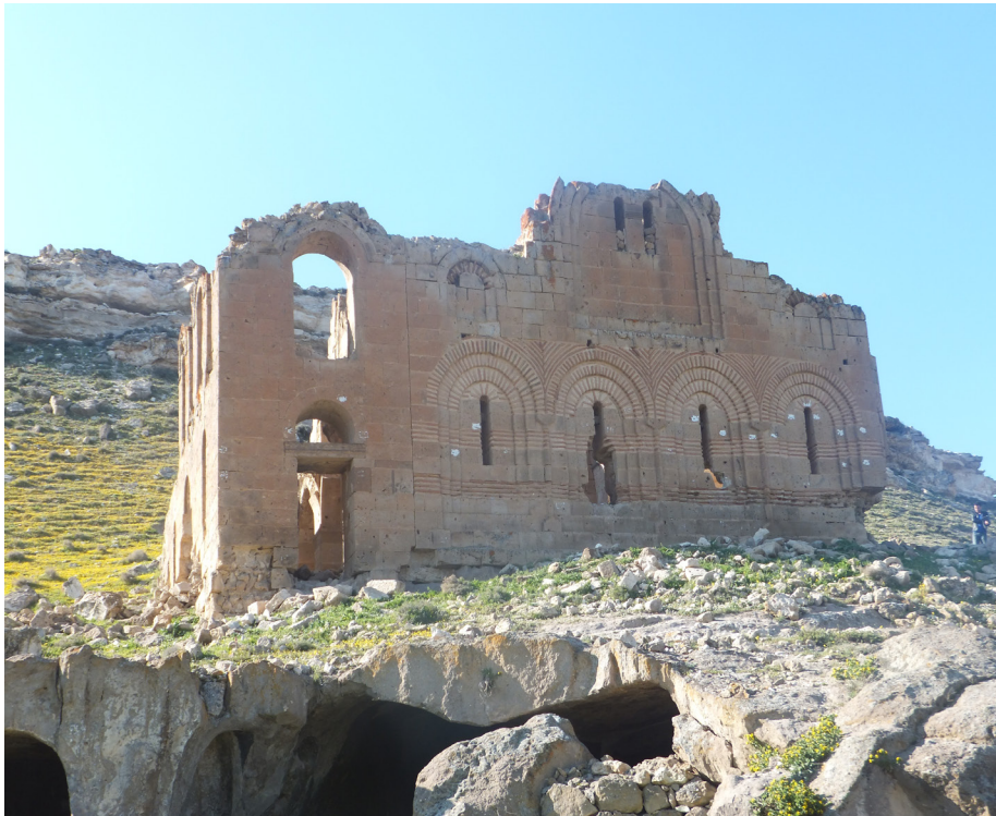
Resim 18. Çanlı Kilise, Güney Cephe, Pencere ve Kemerlerdeki Tuğla Kullanımı, Güneyden Bakış (2013)
