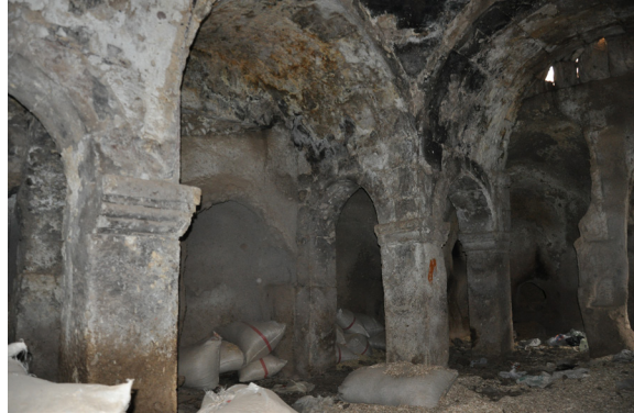
Resim 12. Güzelöz (Mavrucan) H. Eustathios Kilisesi, Doğu ve Güney Haç Kolları Örtü Sistemi, Kuzeybatıdan Bakış (2013).
