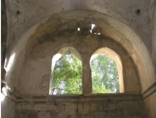
Resim 11. Yeşilyurt Sivri Kilise, Güney Haç Kolu Örtü Sistemi, Kuzeyden Bakış (Pekak Arşivi).
