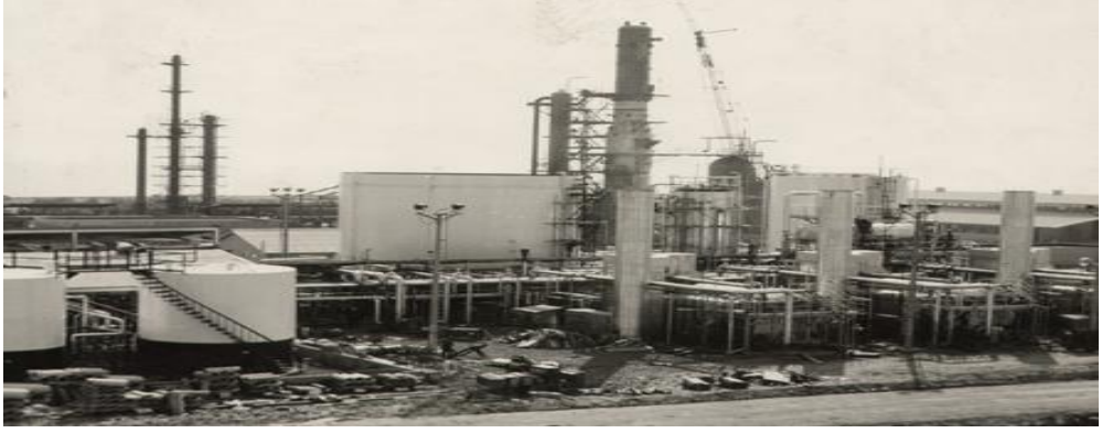
Aliğa Petrol Rafinerisi inşaatından bir görüntü
